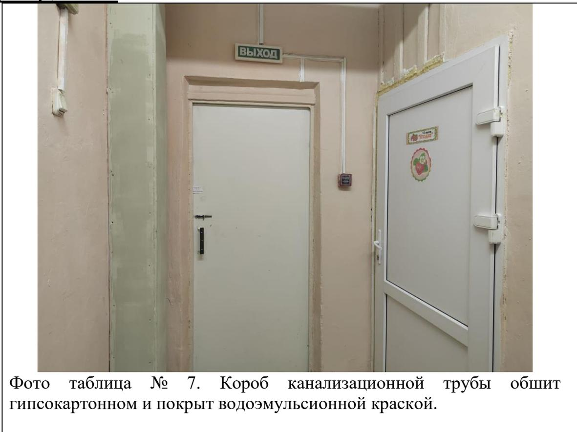
Фото таблица № 7. Короб канализационной трубы обшит гипсокартонном и покрыт водоэмульсионной краской.
