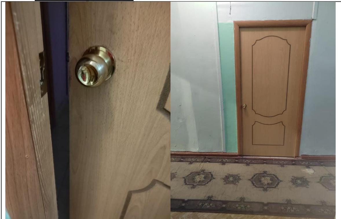
Фото таблица № 4. Дверь эвакуационного выхода, ведущая из холла 1-го этажа в тамбур. Демонтирован врезной замок, установлена ручка по типу «барашек».
